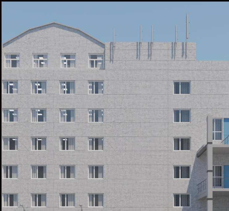
Здание БЦ 7 этажей. Общая площадь – 11 500 кв.м
