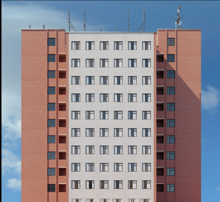
Здание БЦ 11 этажей Общая площадь – 12 300 кв.м
